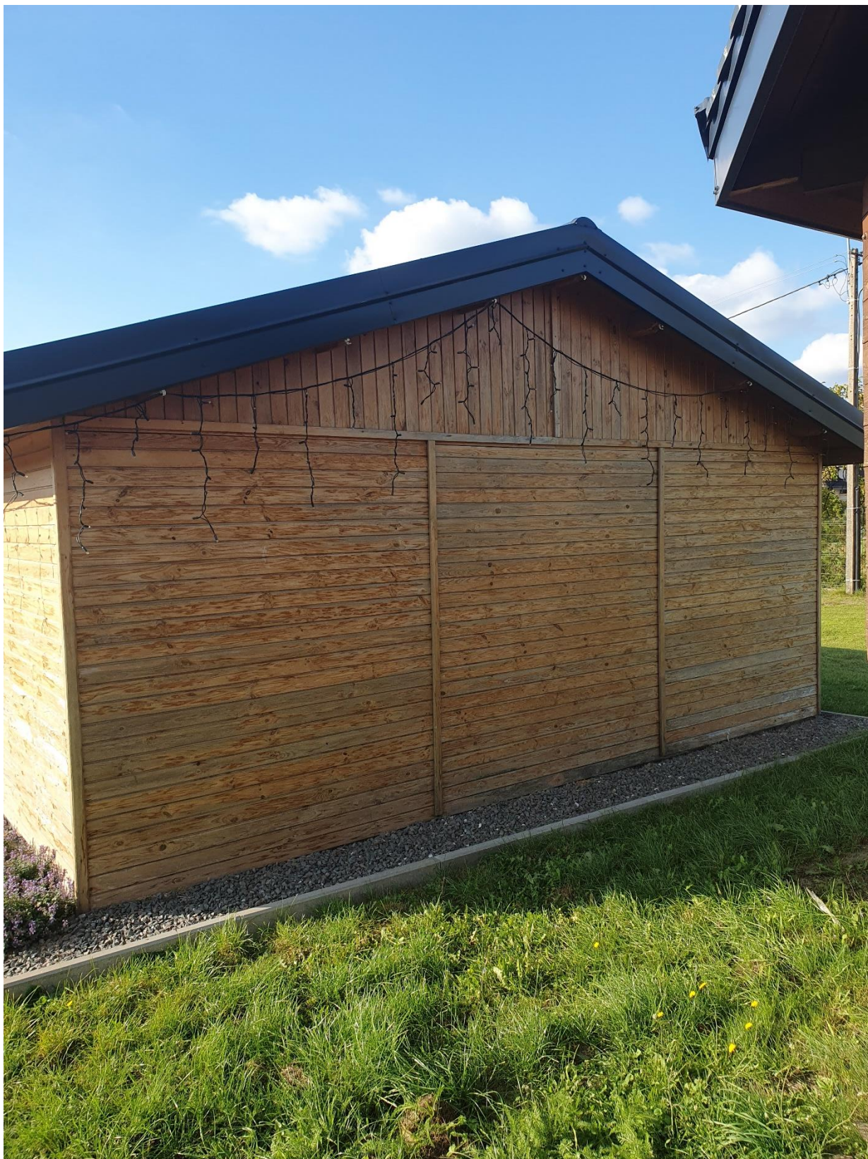
Zdjęcie 3: Widok na elewację tylną. (zdjęcie poglądowe).
