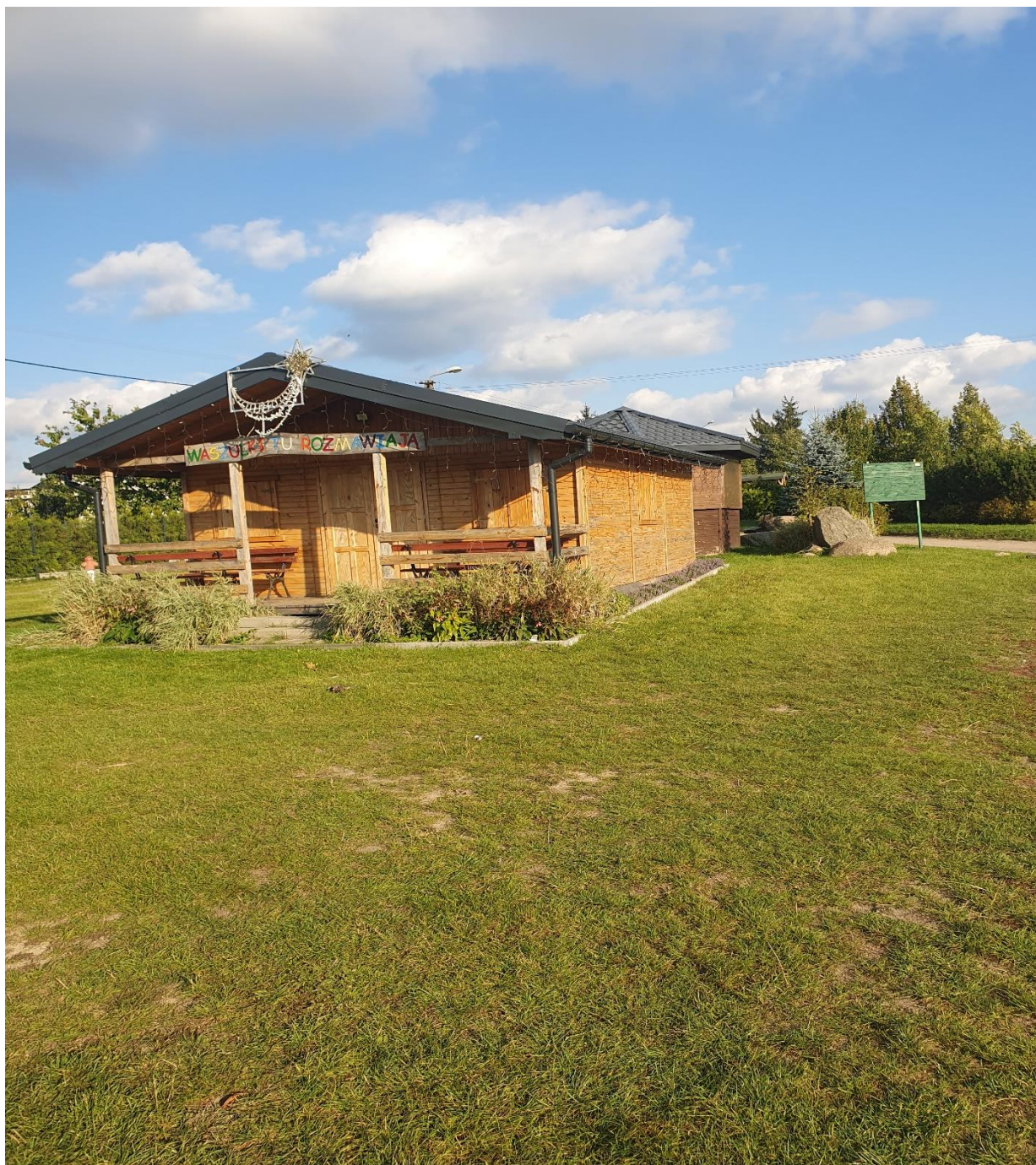
Zdjęcie 1 : Widok na elewację frontową (zdjęcie poglądowe).
