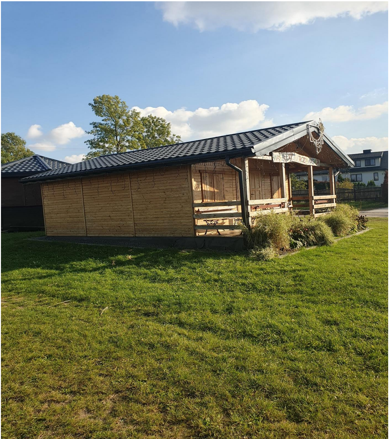
Zdjęcie 2: Widok na elewację boczną (zdjęcie pogładowe).
