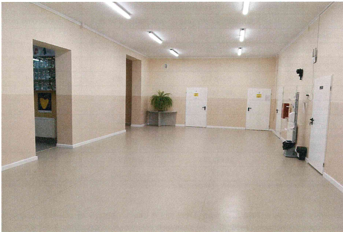
Fot. Korytarz w SP w Petrykozach po remoncie. Fot. Archiwum UG.
