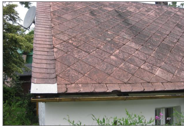
Fot. 2 Płyty azbestowo-cementowe płaskie
