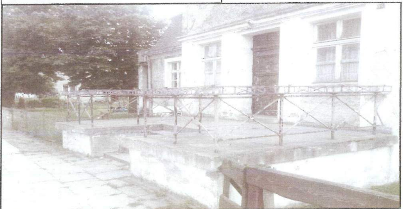
TARAS PRZY ELEWACJI FRONTOWEJ (wsch.)
