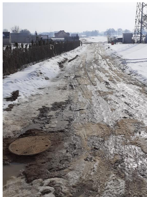
Zdjęcie 4. kanalizacja Filice
