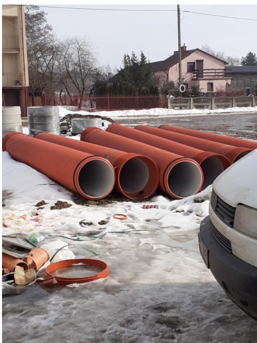
Zdjęcie 3. kanalizacja Filice
