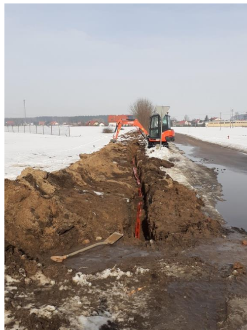
Zdjęcie 2. kanalizacja Filice
