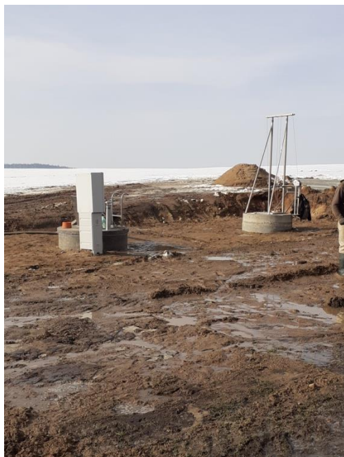
Zdjęcie 1. kanalizacja Filice
